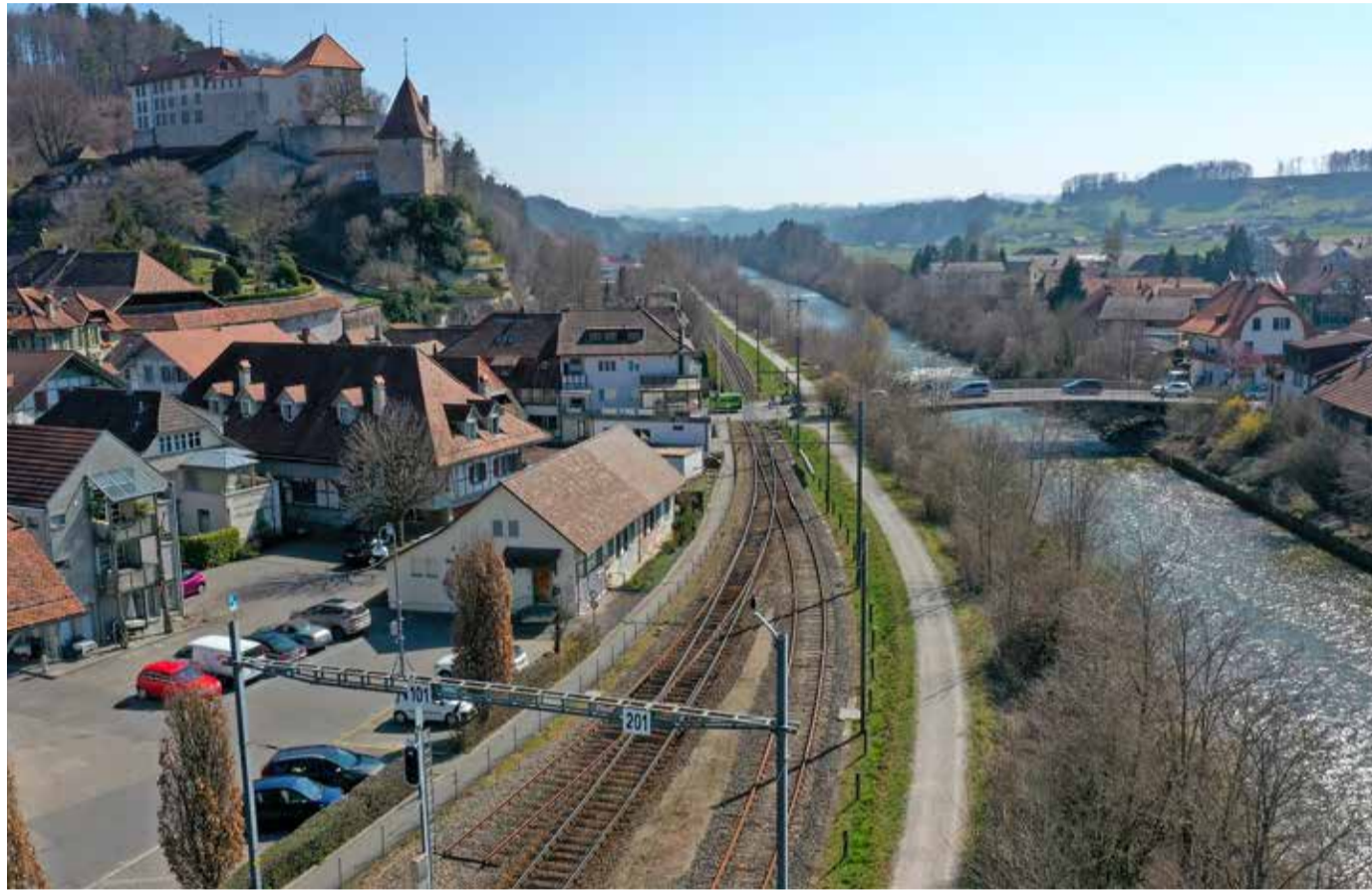
Laupen von oben: Hier sollen ein neuer Bahnhof, neue Kantonsstrassen und eine neue Sensebrücke gebaut werden.
